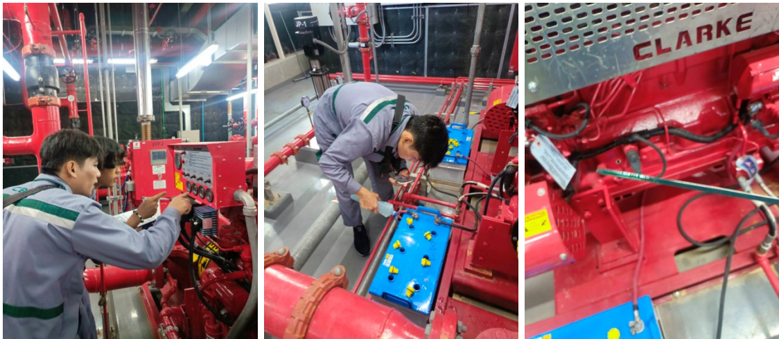
ภาพที่ 3-34 ตรวจสอบระบบปั้มสูบน้ำ
