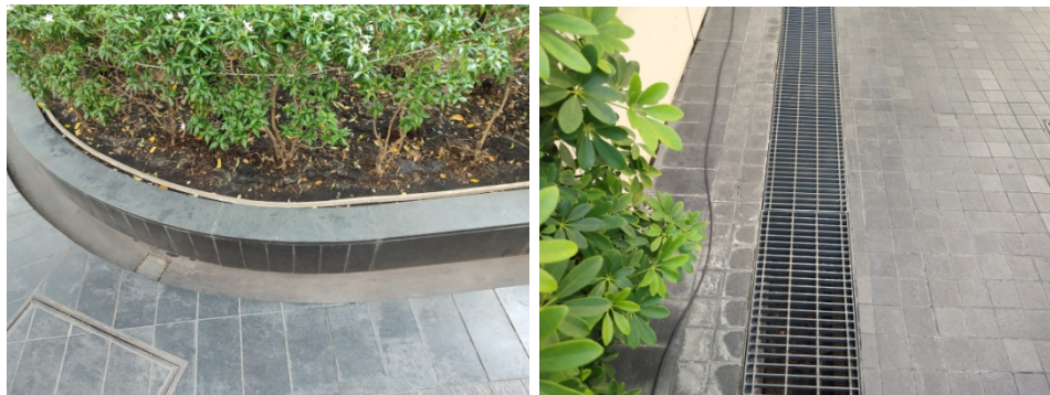
ภาพที่ 3-18 แนวท่อระบายน้ำริมรั้วรอบโครงการ ไม่มีขยะอุดตัน
