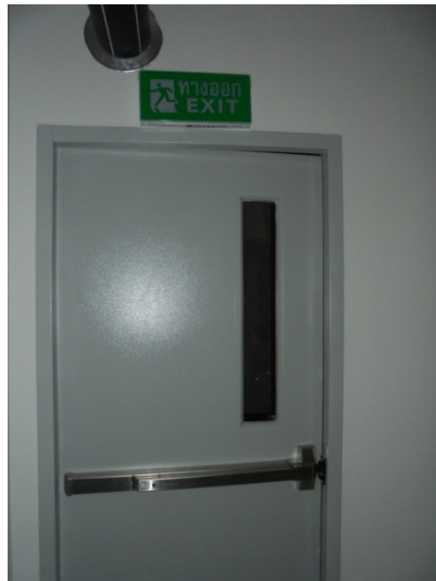
ภาพที่ 3-29 ประตูละไฟและป้ายบอกทางหนีไฟ
